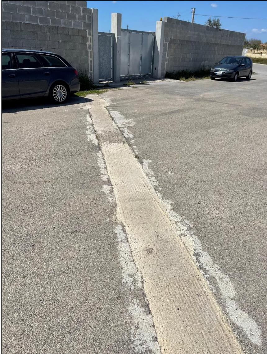
**Fig. 20: Attraversamento cavo corrente elettrica**
