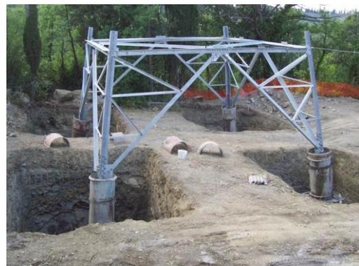
**Figura II.3 - Esempio di fondazione di un sostegno**
