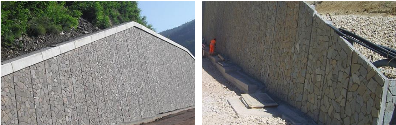
Figura 8 Esempi di pannelli prefabbricati con matrice effetto pietra
