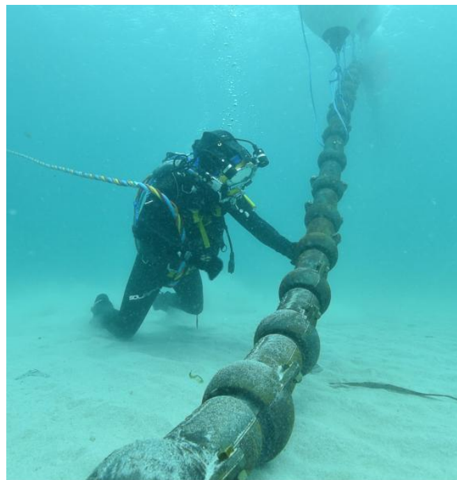
Figura 4-12: Esempio di metodo di posa con gusci di protezione
