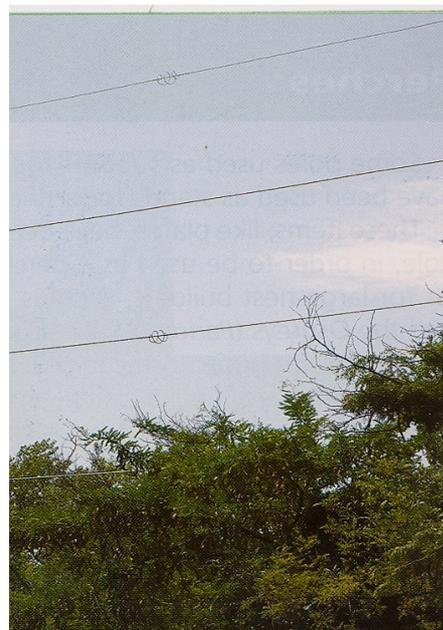
Fig. 35: Schema di spirale ed elettrodotto dotato di spirali che sovrasta il bordo di un bosco.
