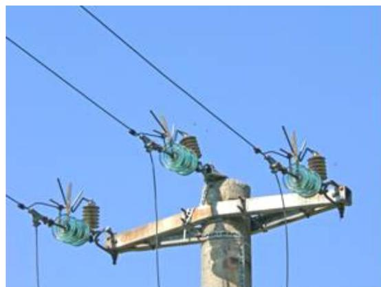
Fig. 18: Dispositivo spinterometrico.
