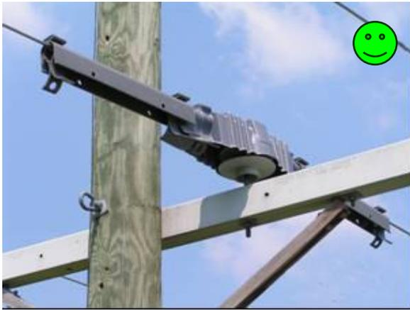
Fig. 47: Isolanti per isolatori portanti.
