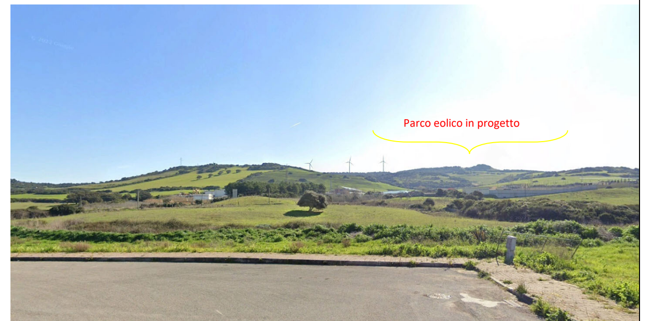
Ps 28 Stato di fatto e di Progetto- Centro abitato comune di Tergu
