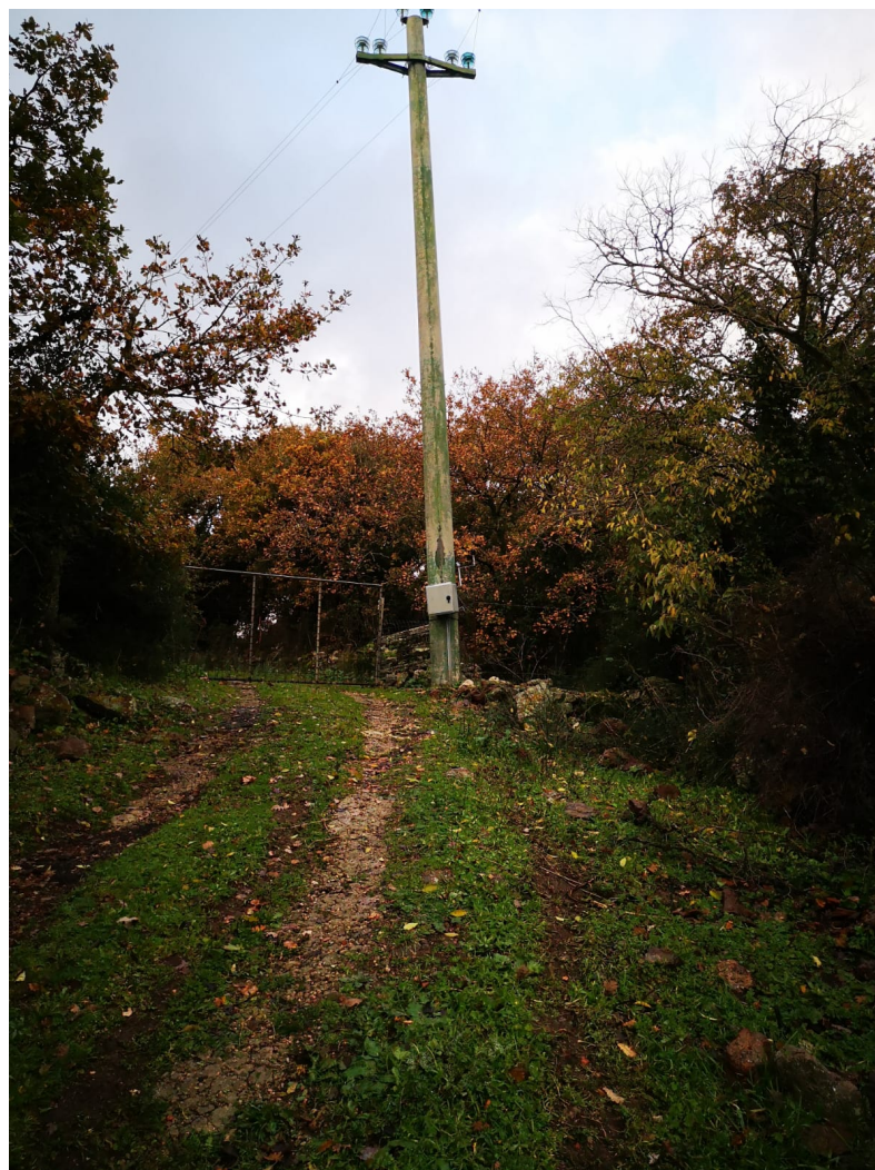
Figura 13 – Misura M3 – vista e posizione strumento di misura
