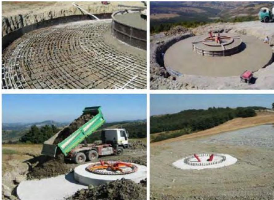
Figura 32 – Fasi di realizzazione del plinto di fondazione dell'aerogeneratore
