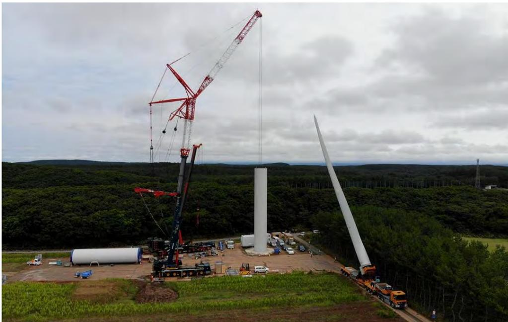
Figura 29 – Fasi di montaggio della torre dell'aerogeneratore
