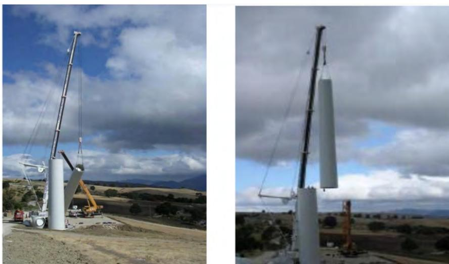
Figura 38 – Fasi di montaggio della torre dell'aerogeneratore
