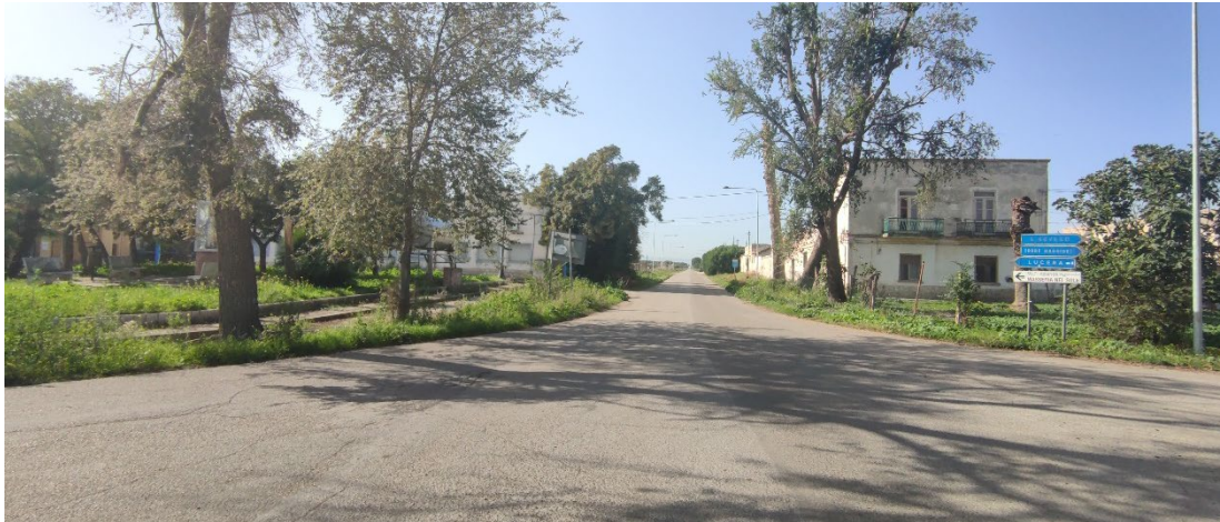
Viabilità in conglomerato bituminoso esistente
