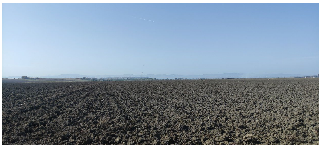
Accesso WTG LU02 – Realizzazione nuova viabilità parco eolico
