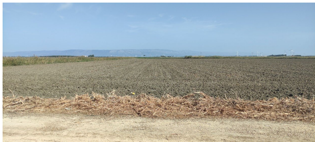
Accesso WTG LU07 – Realizzazione nuova viabilità parco eolico in aree perimetrate ADB
