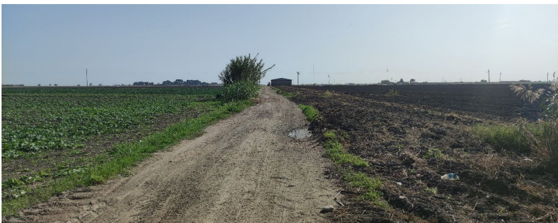
Viabilità esistente con pavimentazione naturale in discreto stato
