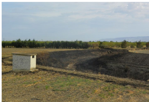
Alveo di T. Vulgano percorso da incendio
