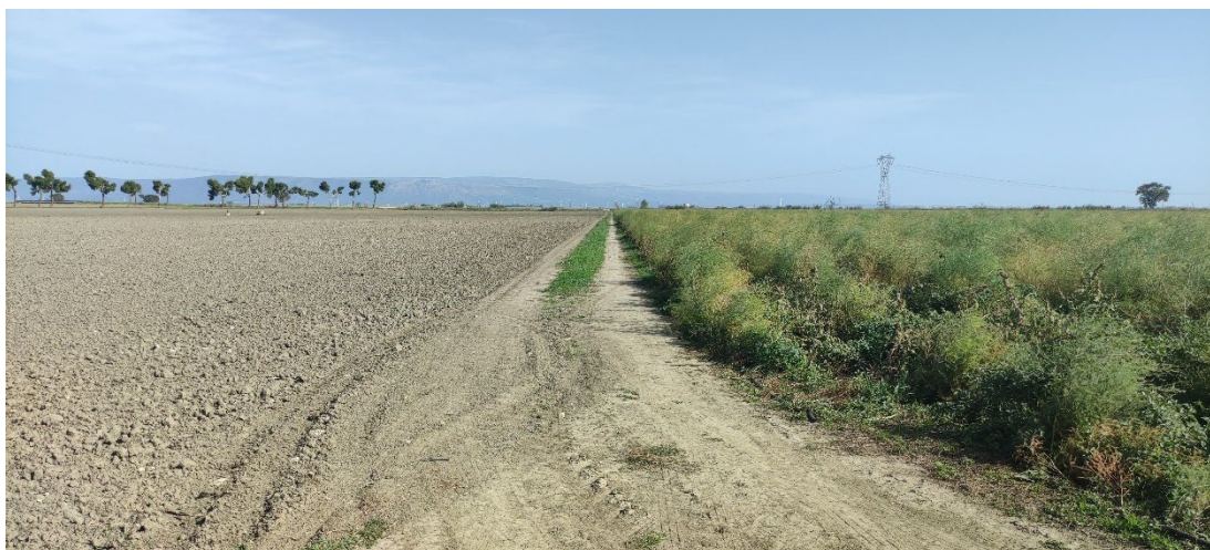
Viabilità esistente con pavimentazione naturale in pessimo stato
