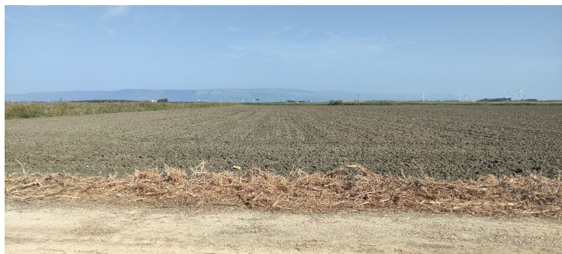
Accesso WTG LU07 – Realizzazione nuova viabilità parco eolico in aree perimetrare ADB
