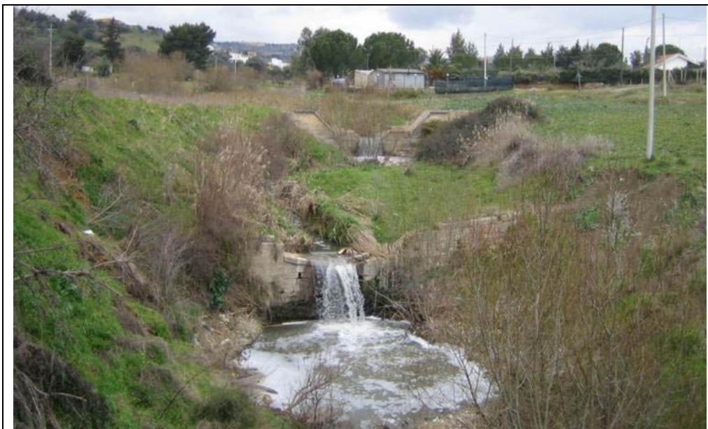
Vallone Mumia: Vista di briglie in c.a. esistenti.
