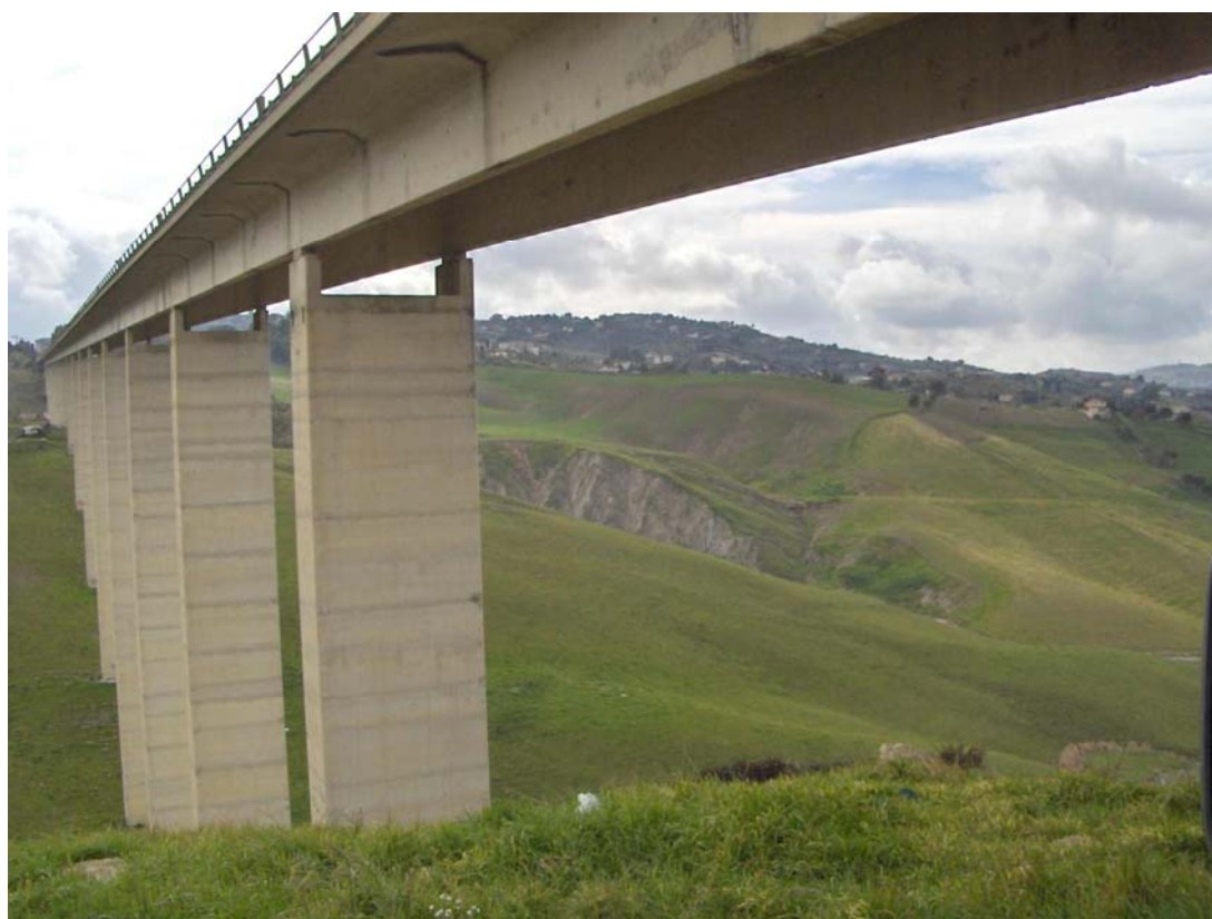
C.da Busita –Affioramenti di argille in prossimità del viadotto esistente.
