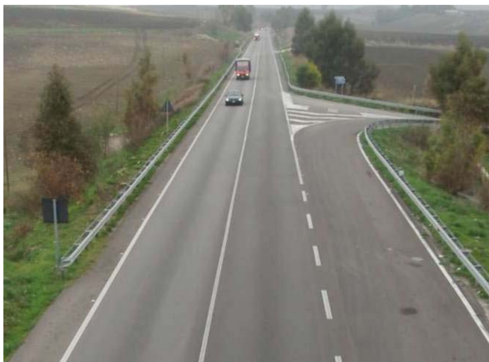
Vista di un tratto dell’attuale S.S. 640
