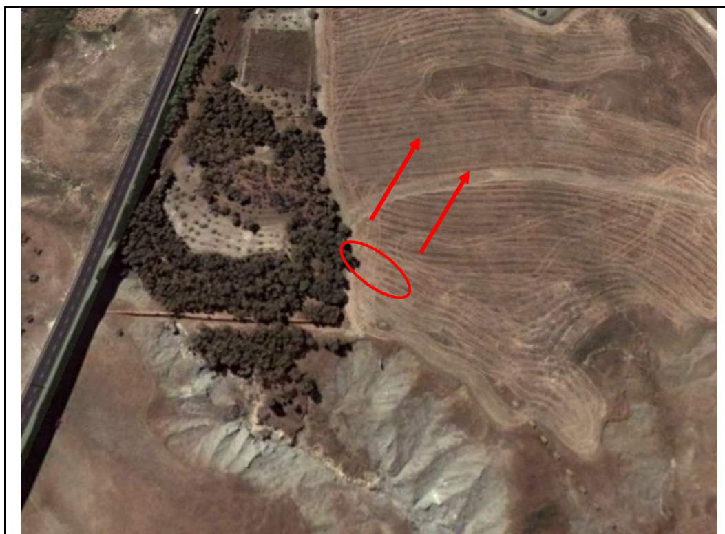
Galleria Caltanissetta settore finale; cerchiato in rosso la zona imbocco lato CL
