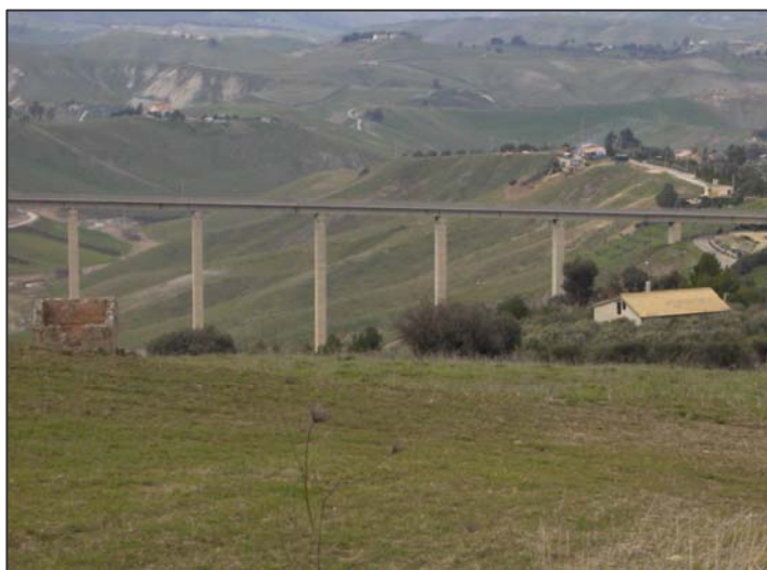
C.da Busita: viadotto esistente della SS640 su versante argilloso
