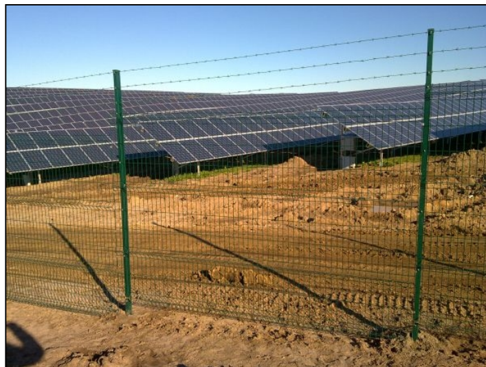
Fig. 6 Esempio di recinzione realizzata con rete metallica
