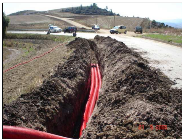
Figura 7: Foto illustrativa della messa in posa dei cavidotti MT
