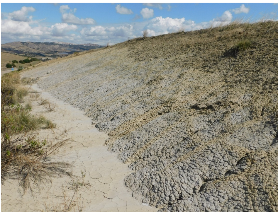
Foto n. 7 - Argille marnose grigioazzurre, in prossimità del sito di progettazione
