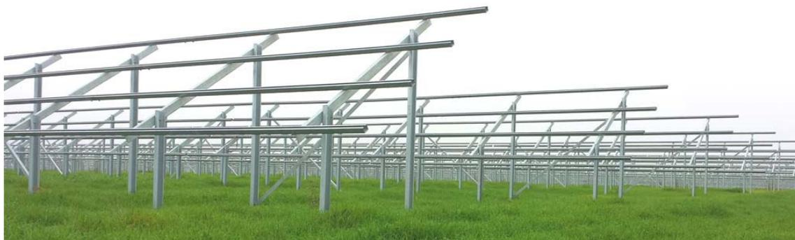
Figura 9 - Strutture di sostegno dei pannelli fotovoltaici
