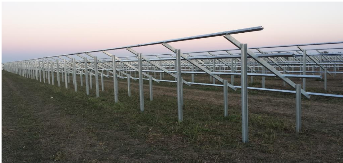
Figura 5: - Stato cantiere al termine della fase lavorativa
