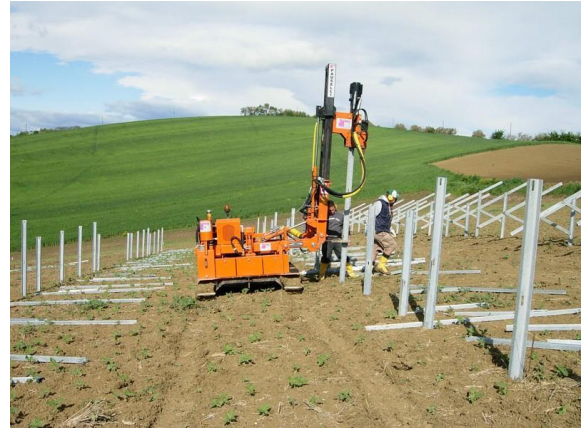
Figura 4 - Posa strutture metalliche di fondazione
