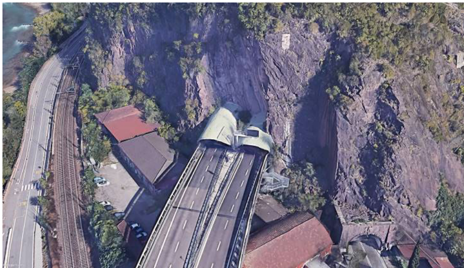
Portali d'imbocco Galleria A22 – Lato Verona
