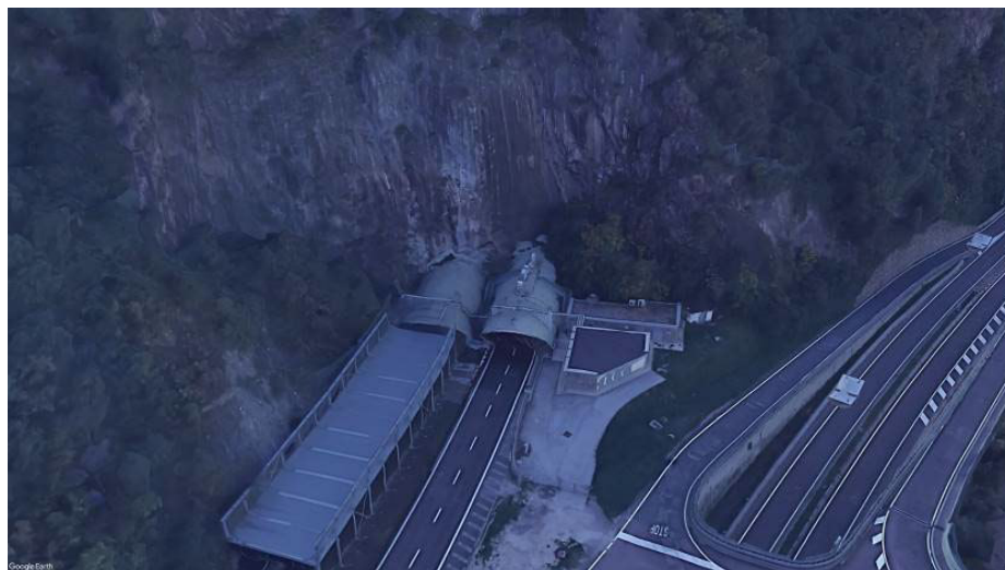
Portali d'imbocco galleria A22 – Lato Bolzano
