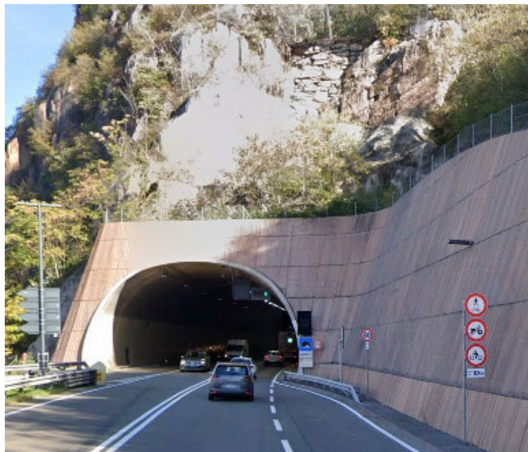
Esempio di ricoprimento con materiale congruente, per colorazione, alla parete retrostante - Imbocco Circonvallazione di Laives
