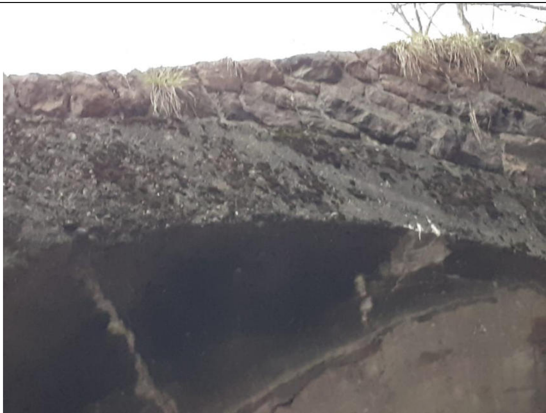
Dettaglio arco lato Nord
