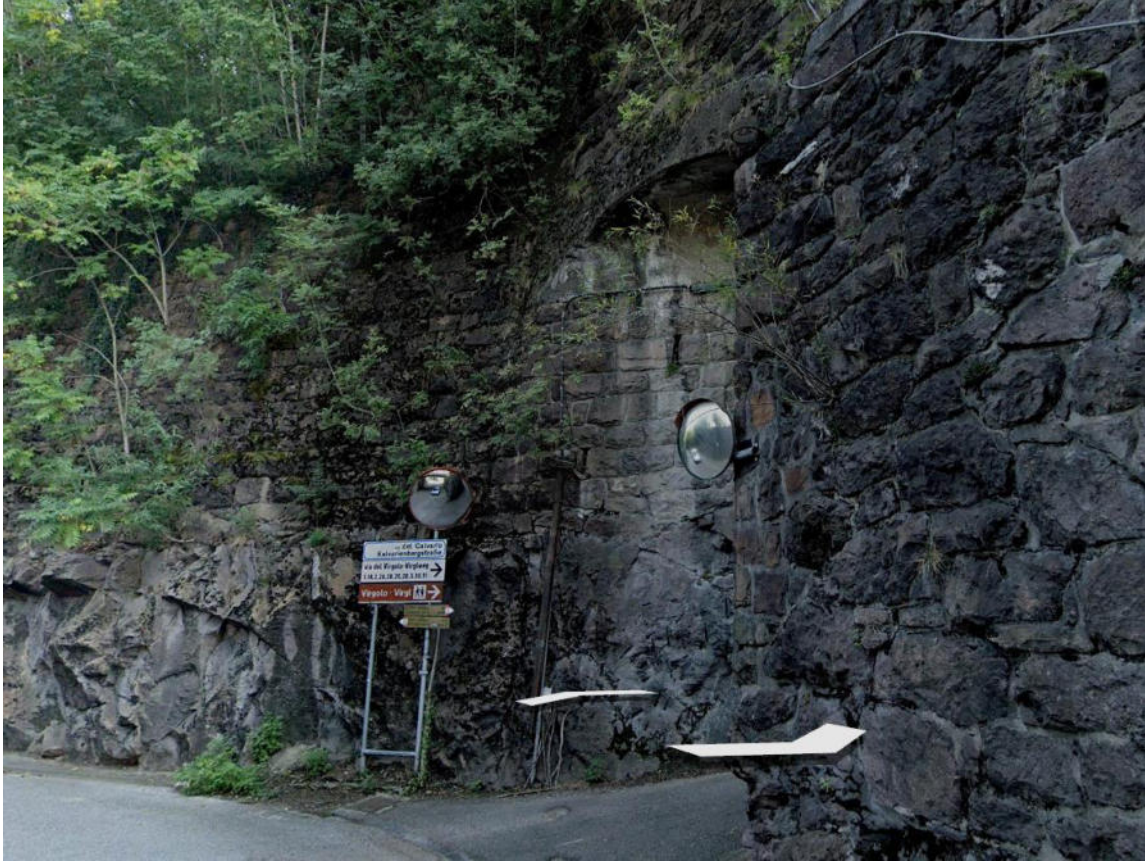
Vista Sud - Est
