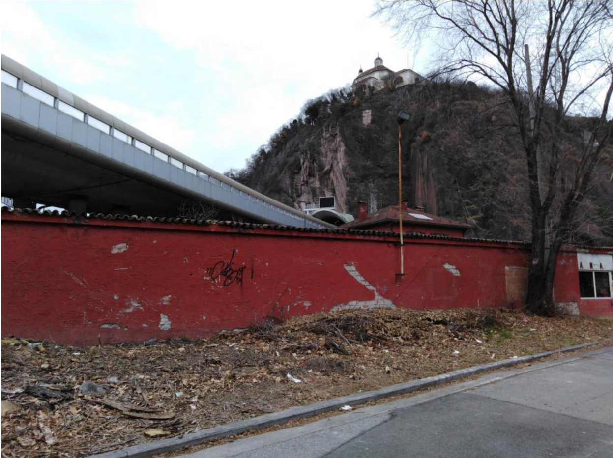
Fab-01 Muro esterno lato strada di accesso
