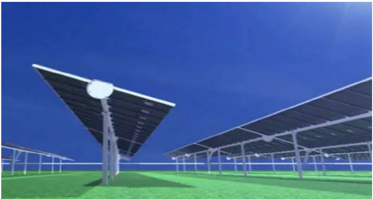
Figura 3-1: esempio moduli fotovoltaici su tracker
