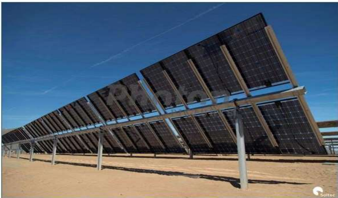
Impianto con strutture mobili ad inseguimento monoassiali
