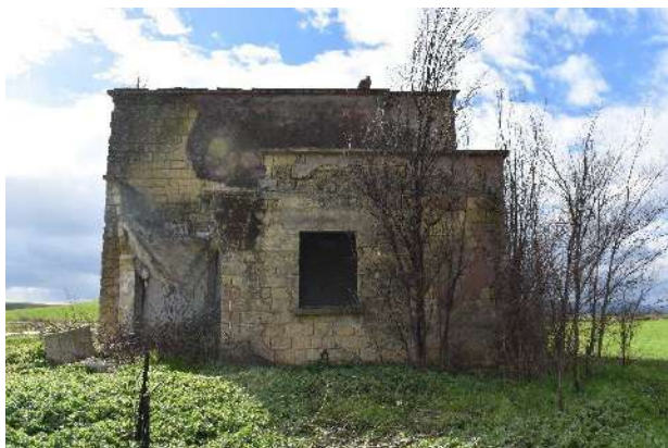
Foto 7: dettaglio della masseria ubicata a Sud Est del campo
