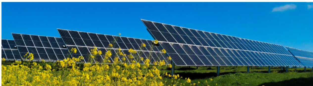
Fig. 16. Layout di impianto ad inseguitori monoassiali di rollio, con pannelli bifacciali montati perpendicolarmente all'asse di rotazione.
