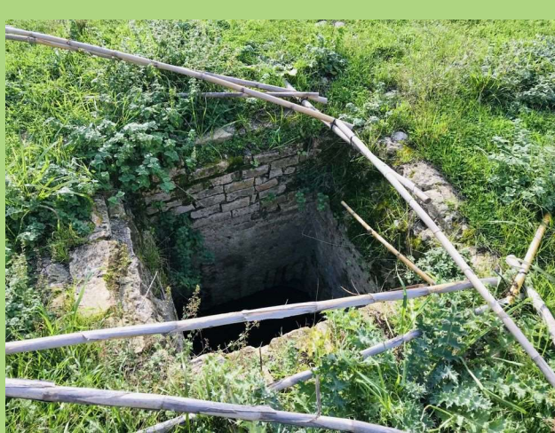
Foto 29. Abbazia di Sant'Agata, bocca della cisterna al centro del chiostro.
