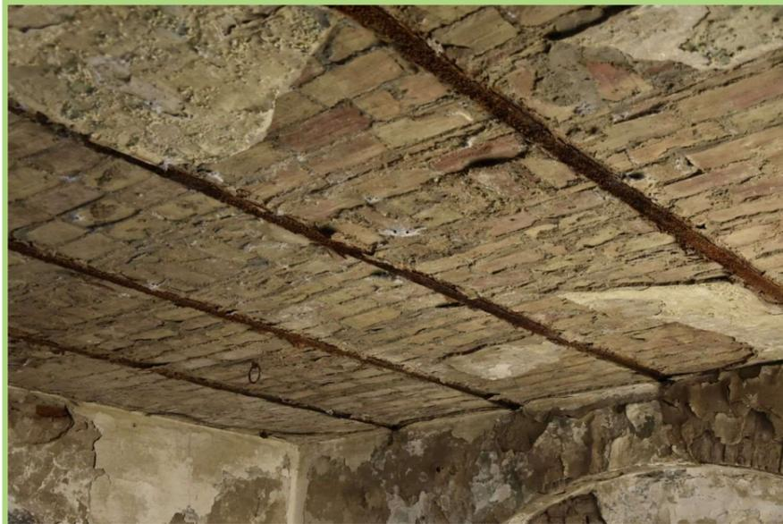
Foto 37. Massera Bufalara, particolare di solaio a putrelle e mattoncini laterizi.
