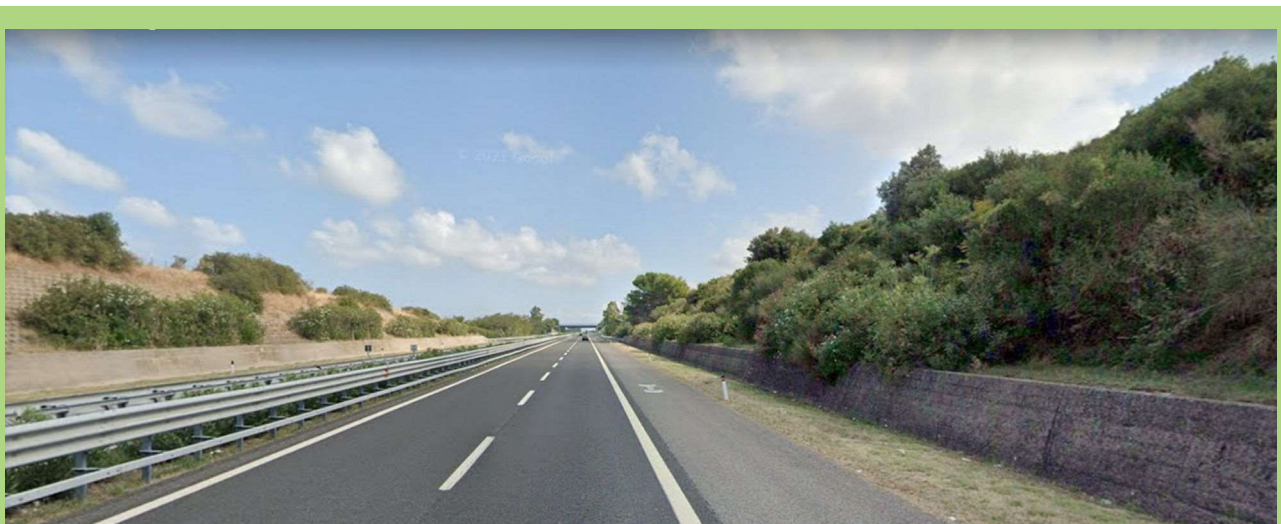
Foto 48. Sequenza visiva dall'autostrada A14, UCP delle Strade panoramiche, in direzione est - 4.
