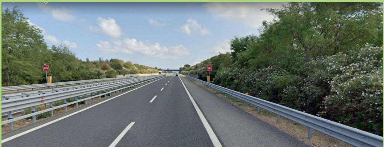
Foto 47. Sequenza visiva dall'autostrada A14, UCP delle Strade panoramiche, in direzione est - 3.
