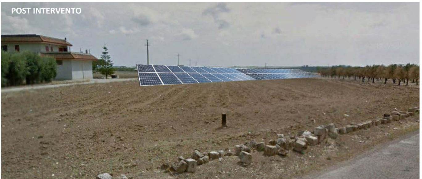
INTERVENTO con MITIGAZIONE
