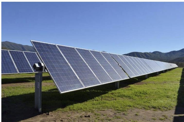
I moduli fotovoltaici saranno installati su singola fila in configurazione portrait (verticale) rispetto all'asse di rotazione del tracker. Ciascun tracker si muove in maniera indipendente rispetto agli altri poiché ognuno è dotato di un proprio motore. L'asse di rotazione (asse principale del tracker) è in linea generale orientato nella direzione nord-sud.
