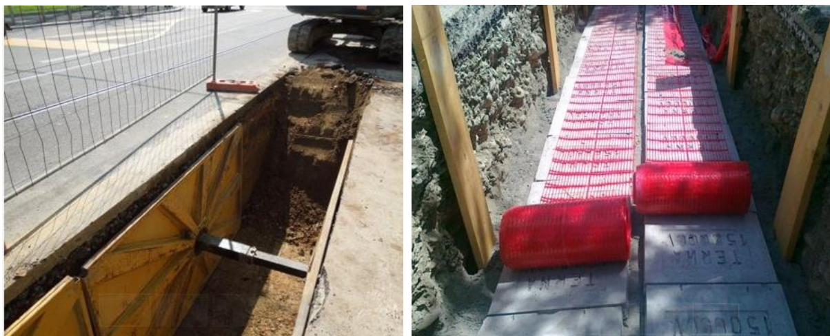
Trincee per posa cavi da interrare
