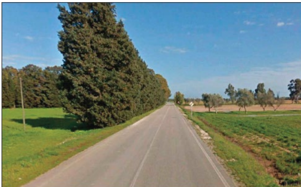
Fronte strada SP 81
