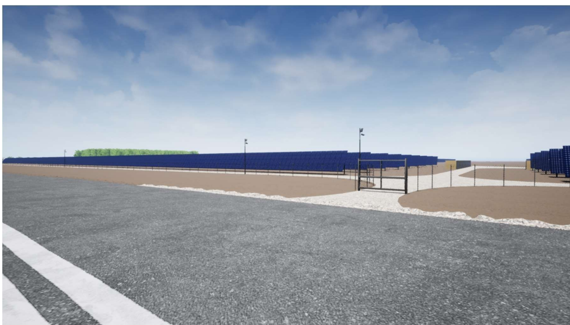
Fotorendering con punto di vista sulla SP 80 senza la piantumazione degli ulivi
