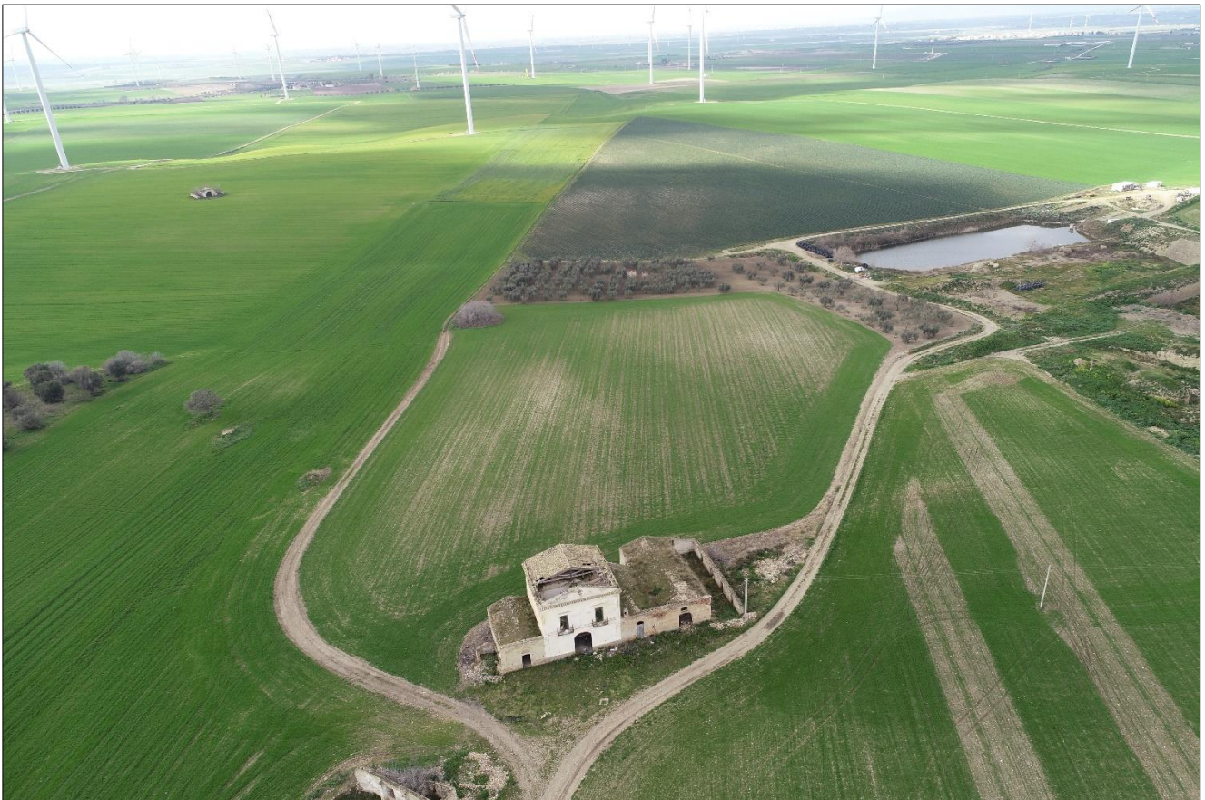
FOTO B - VISTA AEREA AREA LOTTO 2 nord
