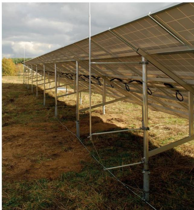
Un impianto di terra costituisce la base per la realizzazione di un'efficace protezione contro sovratensioni e fulmini negli impianti fotovoltaici. Grazie all'interconnessione degli impianti di terra si realizza una superficie equipotenziale che riduce notevolmente la tensione sulle linee di collegamento elettrico in caso di interferenza da fulmine tra i gruppi FV e gli edifici operativi. Per
