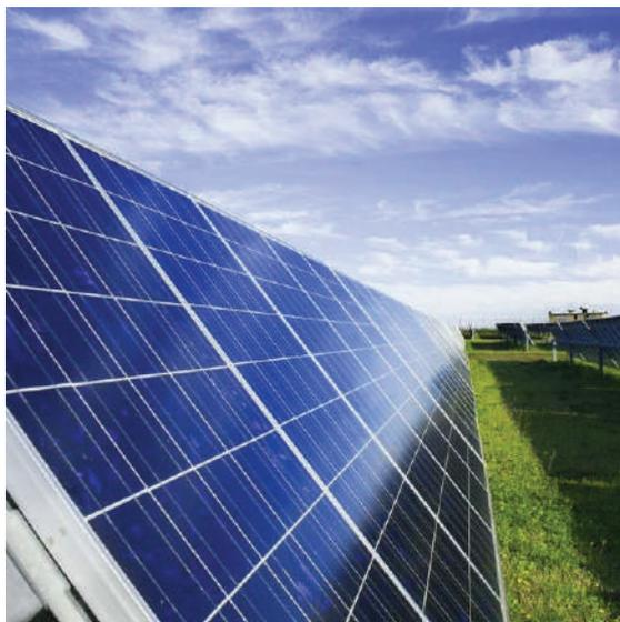
Il tracker monoassiale è di tipo orizzontale ad asse singolo ed utilizza dispositivi elettromeccanici per inseguire il sole durante tutto il giorno da est a ovest sull'asse di rotazione orizzontale nord-sud
