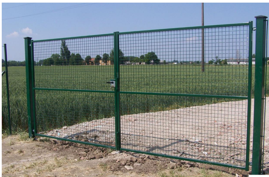
Figura 03- Esempio tipologico cancello della recinzione perimetrale
