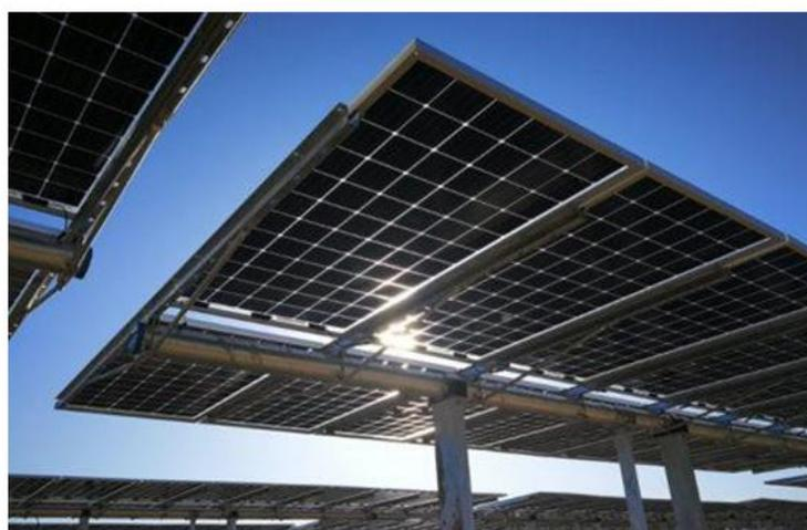
Figura 2.5: Particolare strutture tipo trackers di sostegno moduli
