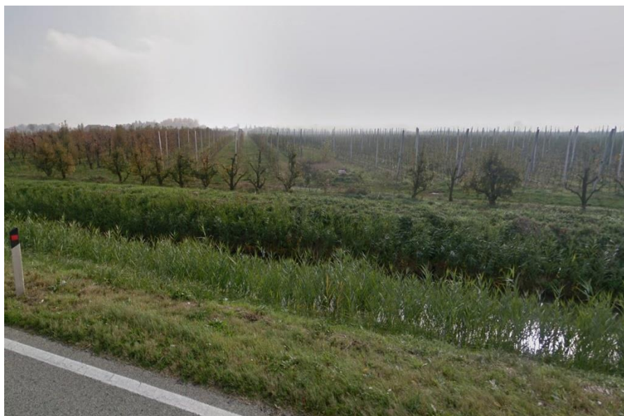
Figura 3.5: Elemento idrico in canale interno all'impianto CAN_A02.
