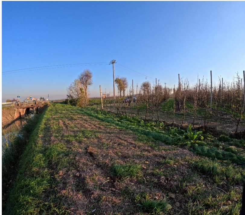
Figura 3.3: Linea aerea di media tensione MT_A01 (Sud area impianto).
