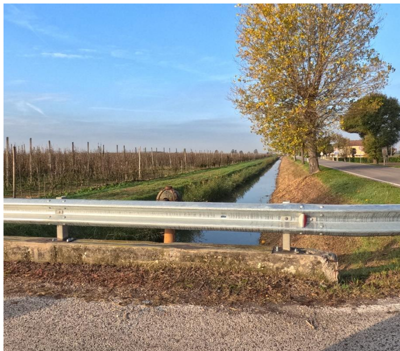
Figura 3.4: Elemento idrico in canale interno all'impianto CAN_A01.
