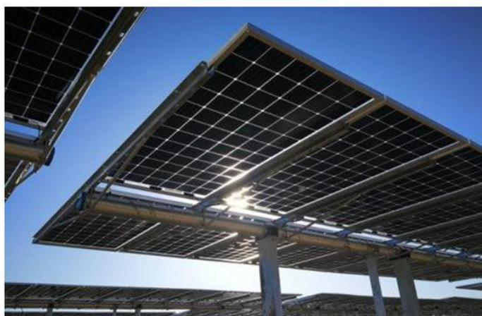
Figura 2.3: Particolare strutture di sostegno moduli
