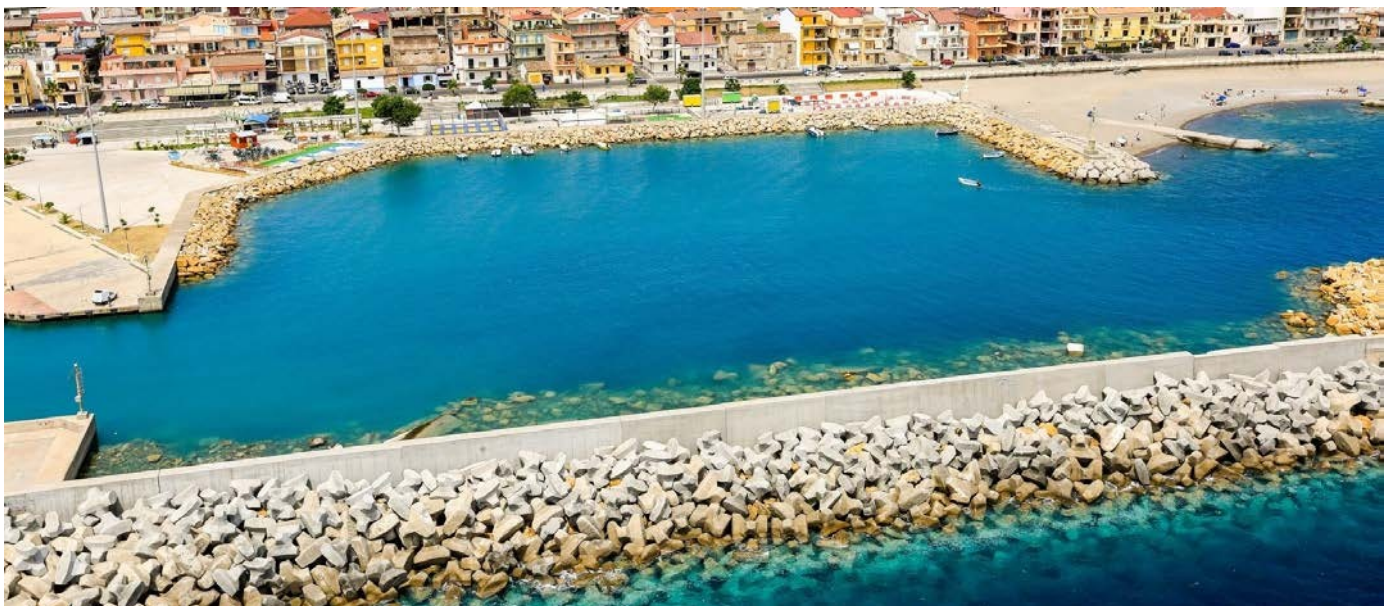
Figura 9.5 Paramento esterno del muro paraonde dell'avamporto parzialmente scoperto
