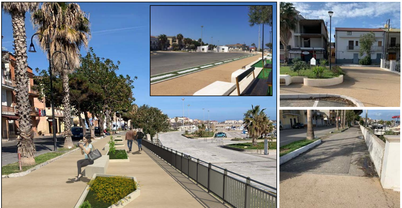
Figura 9.14 Pavimentazione dell'area antistante l'ingresso del porto, da riproporre sulla nuova passeggiata lungomare, e fotoinserimento dell'intervento proposto (in basso a destra: inizio della nuova passeggiata di progetto – stato attuale; a sinistra: foto inserimento nuova passeggiata)
