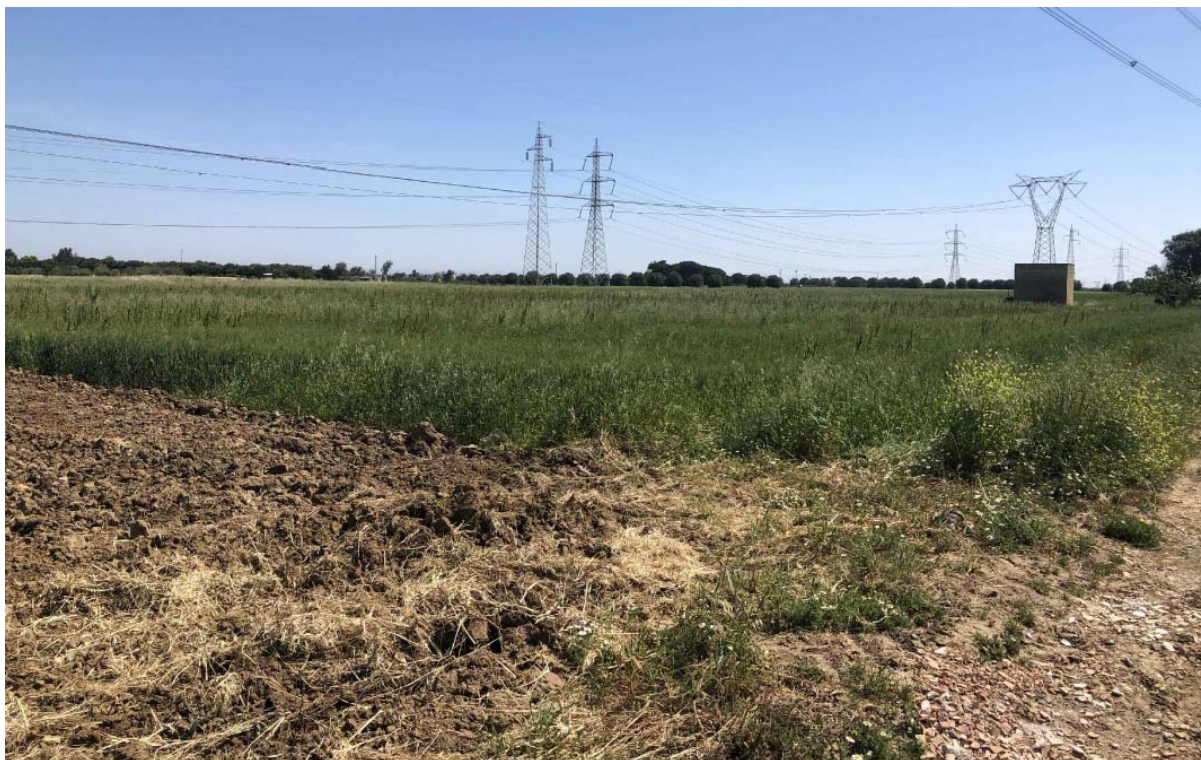
Figura 2-17 - Punto di presa 12 (Sotto-impianto FV-La Gonnella)
