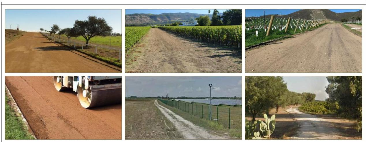
Figura 17-2 Esempi di strade in terra stabilizzata
