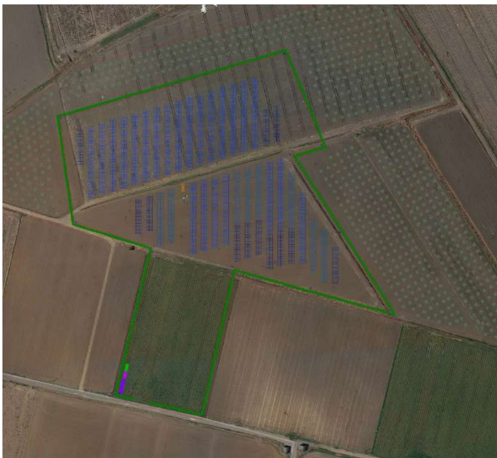
Figura 2-11 - Ortofoto sotto-impianto FV- Restinco (fonte dell'ortofoto: google earth anno di acquisizione dell'immagine 2021)
