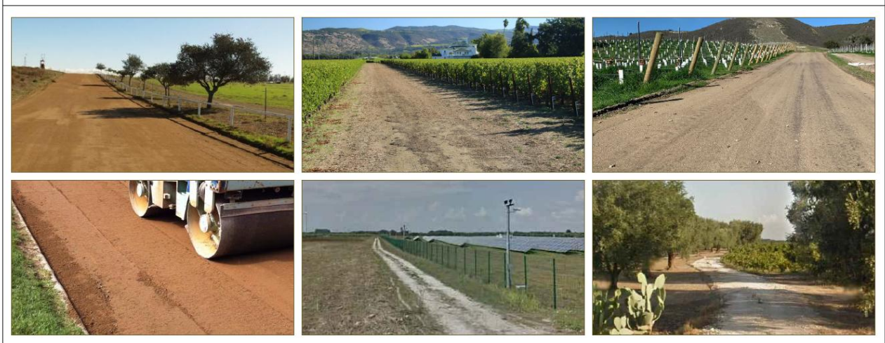
Figura 4-13 Esempi di strade in terra stabilizzata
