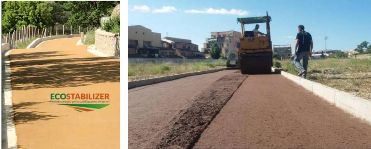
Figura 10-3 - Esempi di strade in terra stabilizzata
