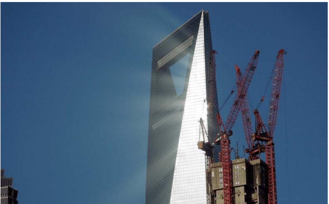
Figura 5 – Esempi tipici di abbagliamento causato da ampie superfici riflettenti (immagine estratta da "VALUTAZIONE DEGLI IMPIANTI FOTOVOLTAICI NEI DINTORNI AEROPORTUALI Ed. n. 1 del 26 aprile 2022")
