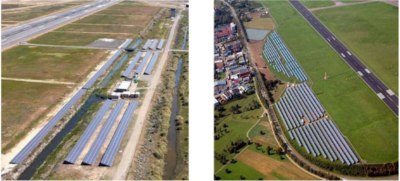
Figura 15 - Esempi di impianti fotovoltaici in ambito aeroportuale. La disposizione dei moduli fotovoltaici in prossimità delle piste di atterraggio/decollo non rappresenta un rischio per la sicurezza.
