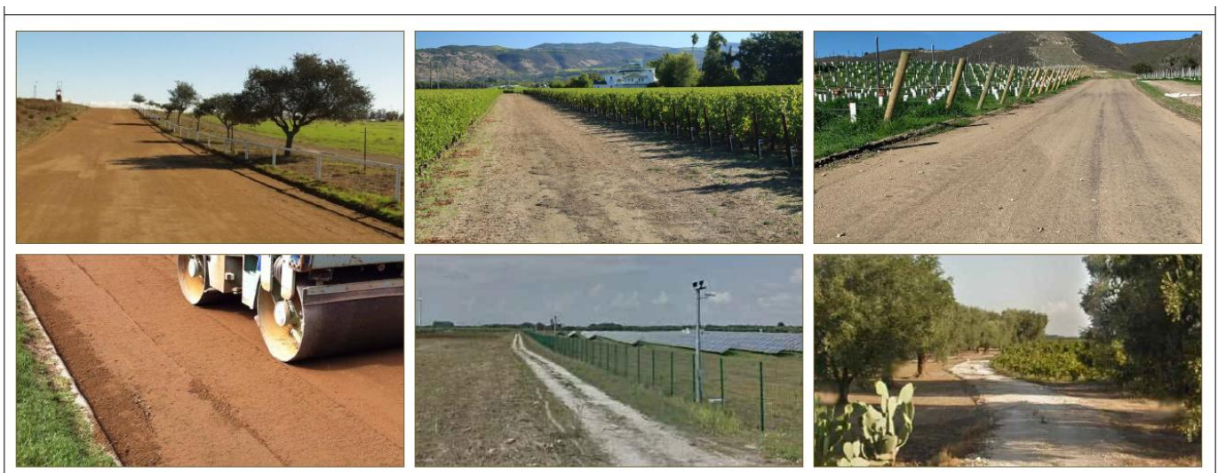
Figura 5-4 - Esempi di strade in terra stabilizzata su terreno agricolo
