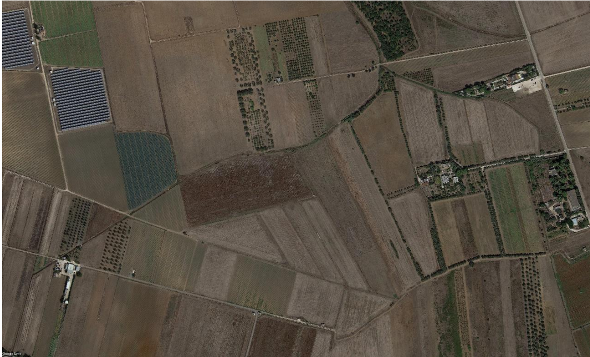
Figura 5-10- Ortofoto dall'alto dell'area di imboschimento sotto-impianto FV-Restinco (stato attuale)
