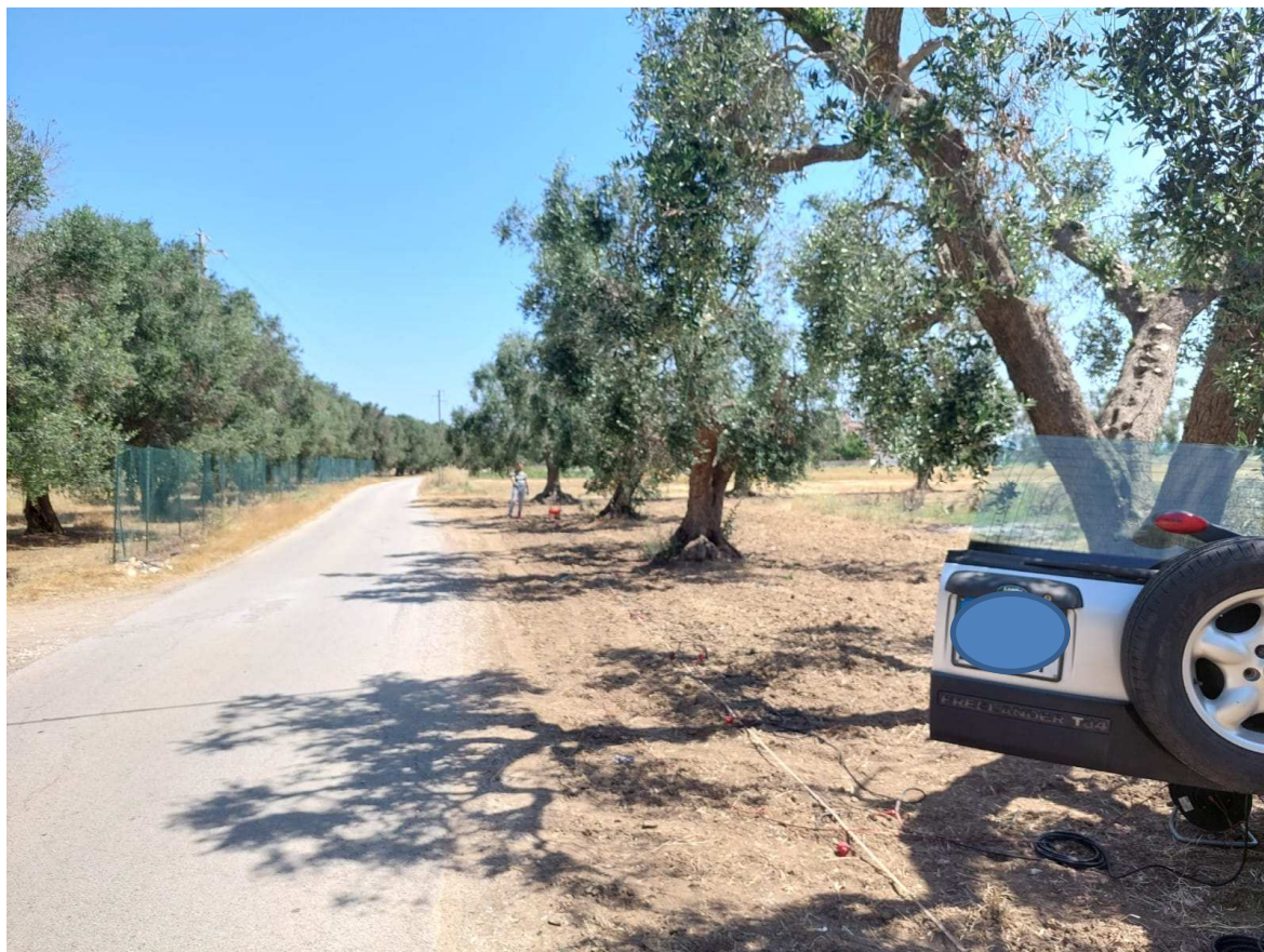
Foto 3: Fase di esecuzione della MASW C-C'
