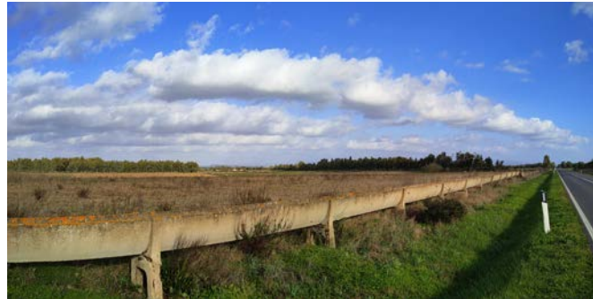
Foto 1 - Ripresa dalla Strada Statale 196 (KM 15+200) a circa 70 metri dai confini sud dell'area di impianto nel comune di Serramanna.
