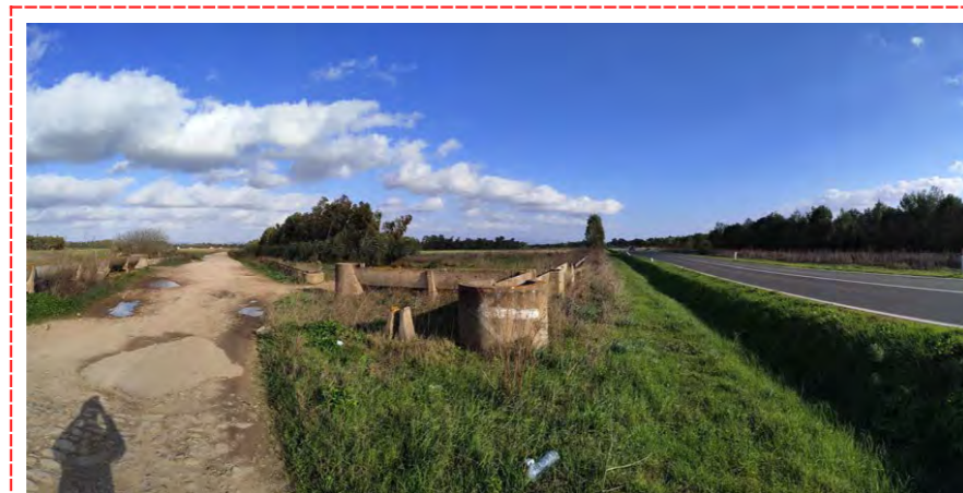
Foto 21 - Ripresa dalla strada comunale in loc. Is Arizollis in prossimità di Riu Sparangallu a 4.400 metri dai confini sud-est di impianto.
