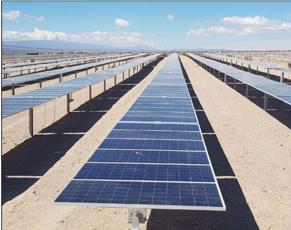
Figura 14 - Foto della struttura di supporto di progetto
