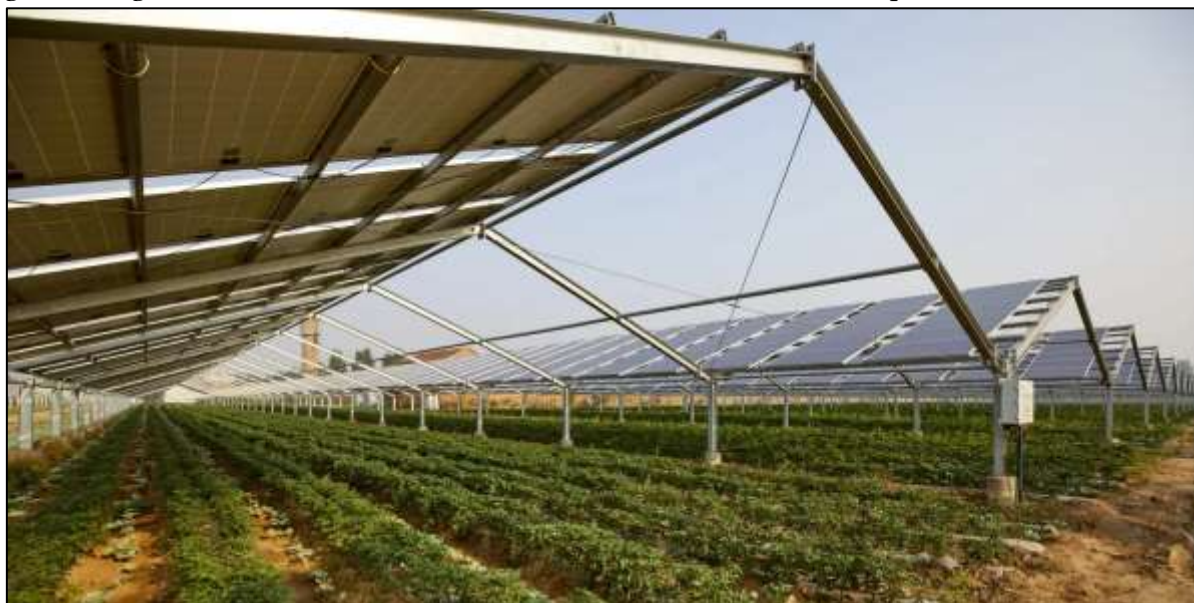
Figura 6.2. Agrovoltaiico a moduli fissi con struttura a falde in Cina, in un campo coltivato a bacche di Goji
