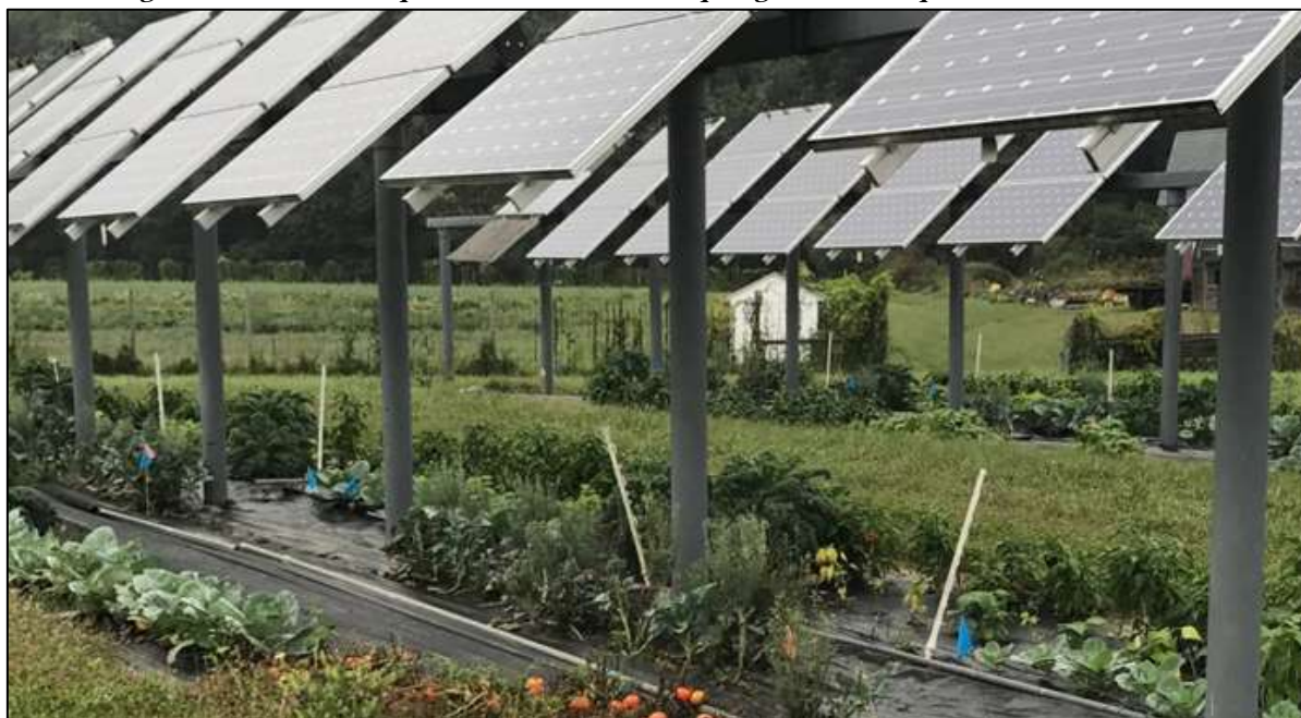
Figura 6.2. Agrovoltaiico a moduli fissi con struttura a falde in Cina, in un campo coltivato a bacche di Goji
