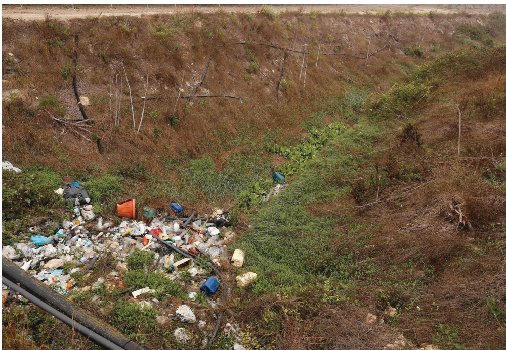
Figura - Episodi di degrado nel Canale La Pidocchiosa all'interno dell'area d'indagine (Foto Studio Rocco Carella).
